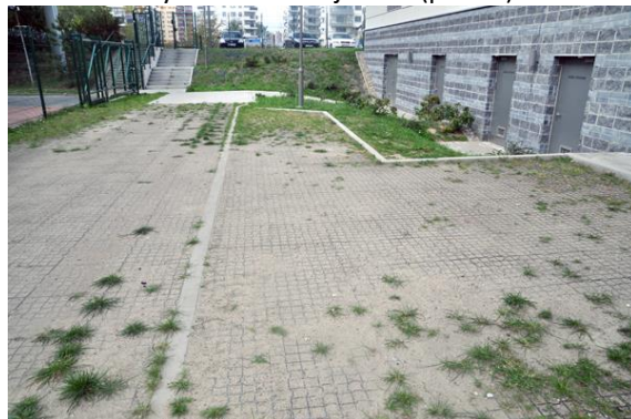
Przykład zastosowania nieprawidłowej odmiany trawy i źle dobranej ziemi (piasku)
