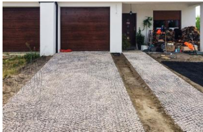
Wjazd do garażu
