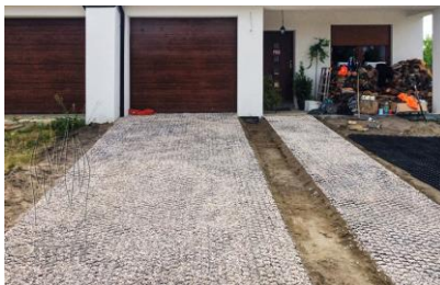
Wjazd do garażu
